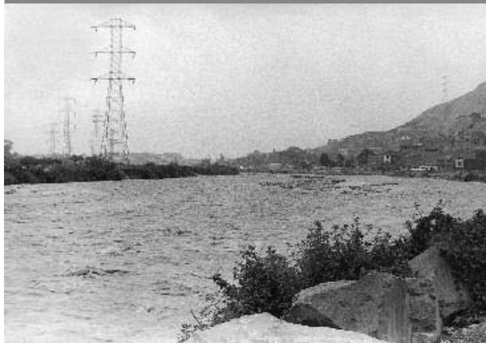
La crecida del río Rímac fue un constante peligro para las torres de transmisión de Lima. En la foto, la localidad de Huachipa y las torres hacia la subestación de Santa Rosa. 1982.
