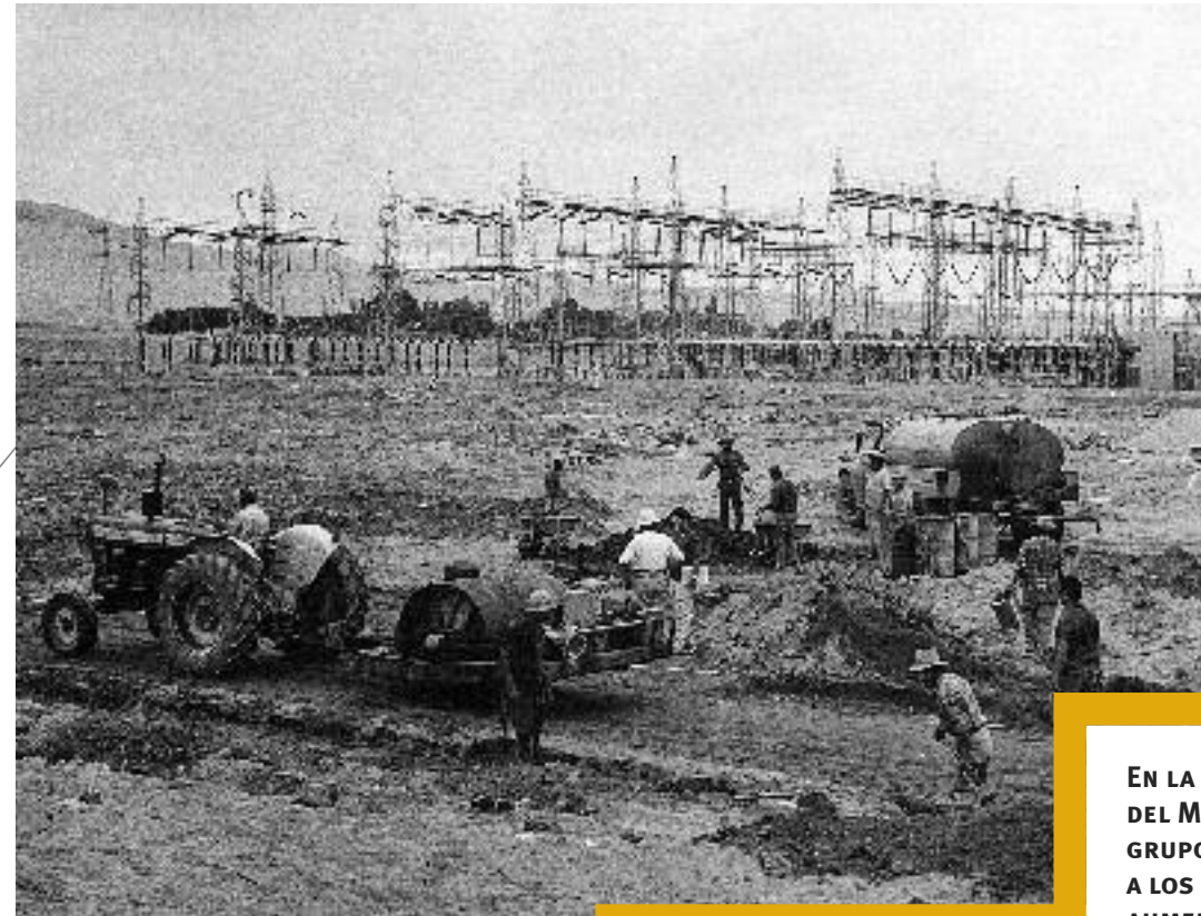
Aspecto de las obras civiles durante la construcción del Patio de Llaves de San Juan, en el lado de EE.EE.AA. Al fondo, el Centro de Transformación San Juan. 1971.
