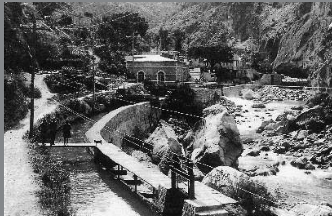
Central Hidroeléctrica Charcani I – 1920. Nótese la línea de transmisión sobre los postes de pino oregón.
