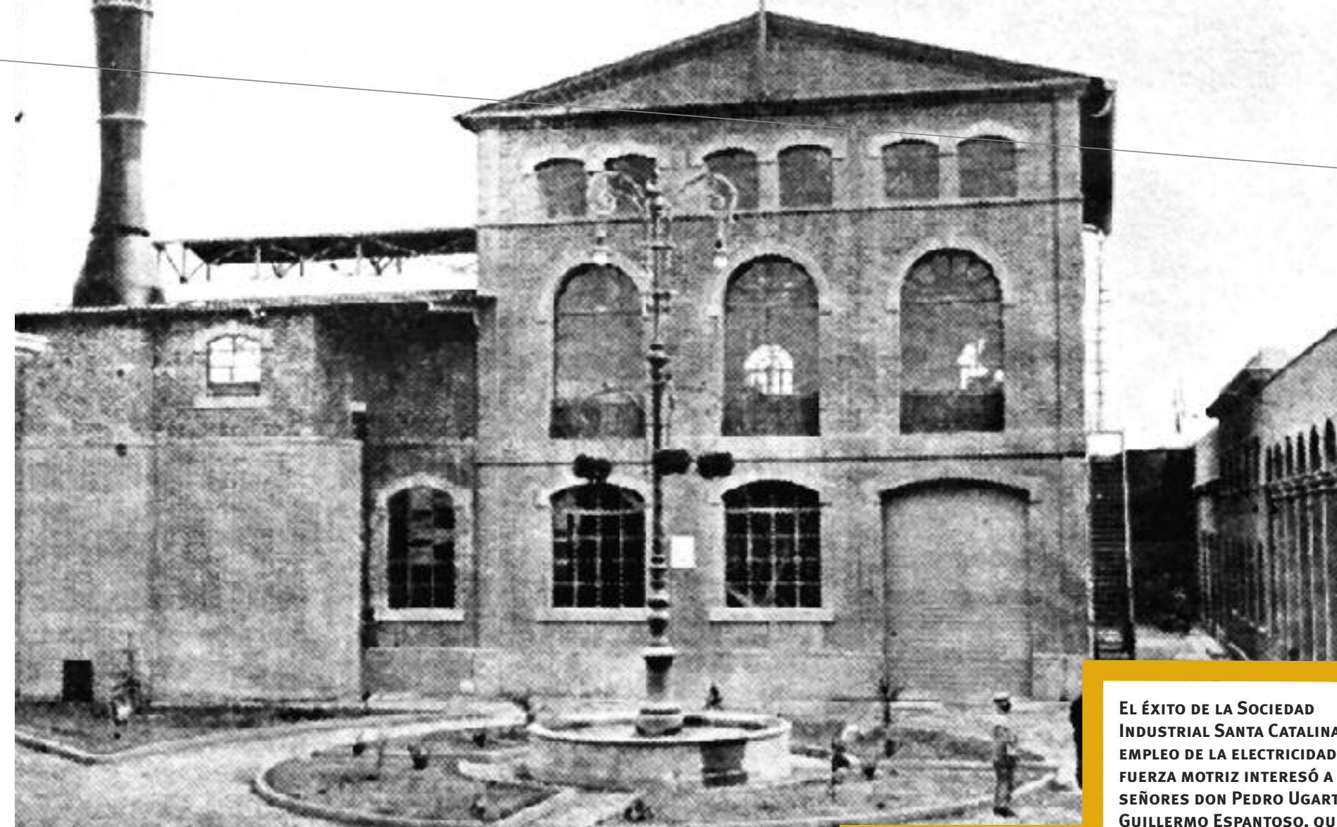
Con la construcción de la central térmica de Santa Rosa en 1899 se dio el verdadero inicio a la industria eléctrica en el Perú.
