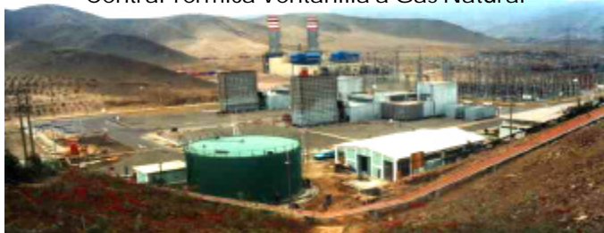
Central Térmica Ventanilla a Gas Natural
