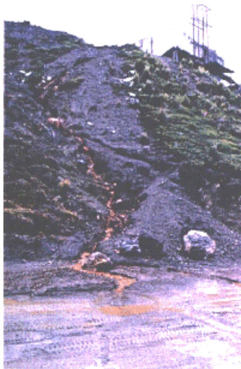
Filtración de botadero de mineral
