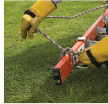
Instale un Tie Off (anclaje portátil, corbata textil) en la base o parte inferior de la escalera, con un mosquetón y un cri cri conectado a él; tense la cuerda (línea de vida) al máximo posible y acóplela al cri cri. Tenga cuidado de colocar la cuerda en el sentido que indica el equipo.
